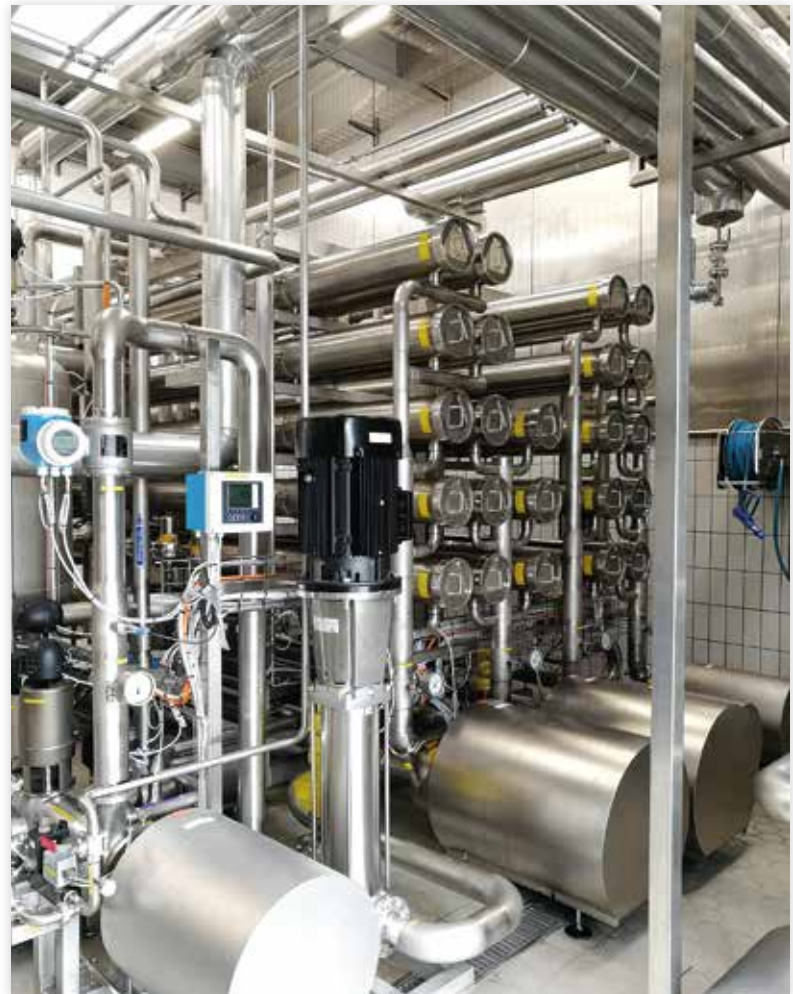
Nanofiltrationsanlage für Mozzarella – Molke (ALPMA) beim Kunden
